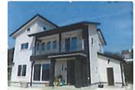
【完成した木造軸組住宅】
