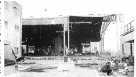
整備が進むセイホク第3工場
