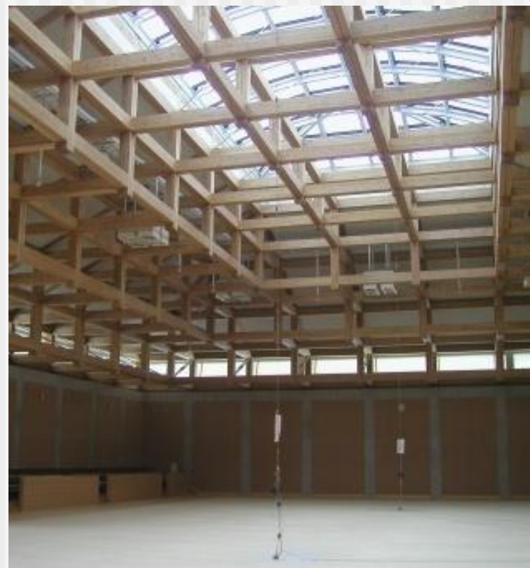
第二道場の屋根骨組み
