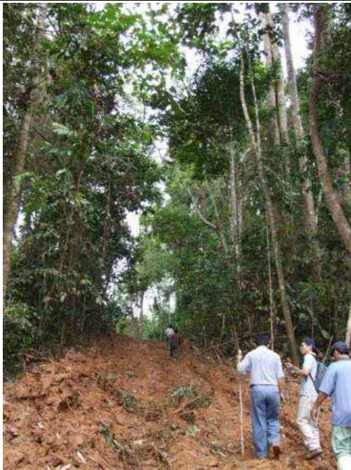
(a) 作業道の様子
